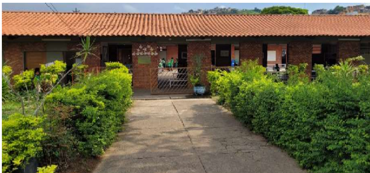
Figura 1 - Foto da entrada da escola
