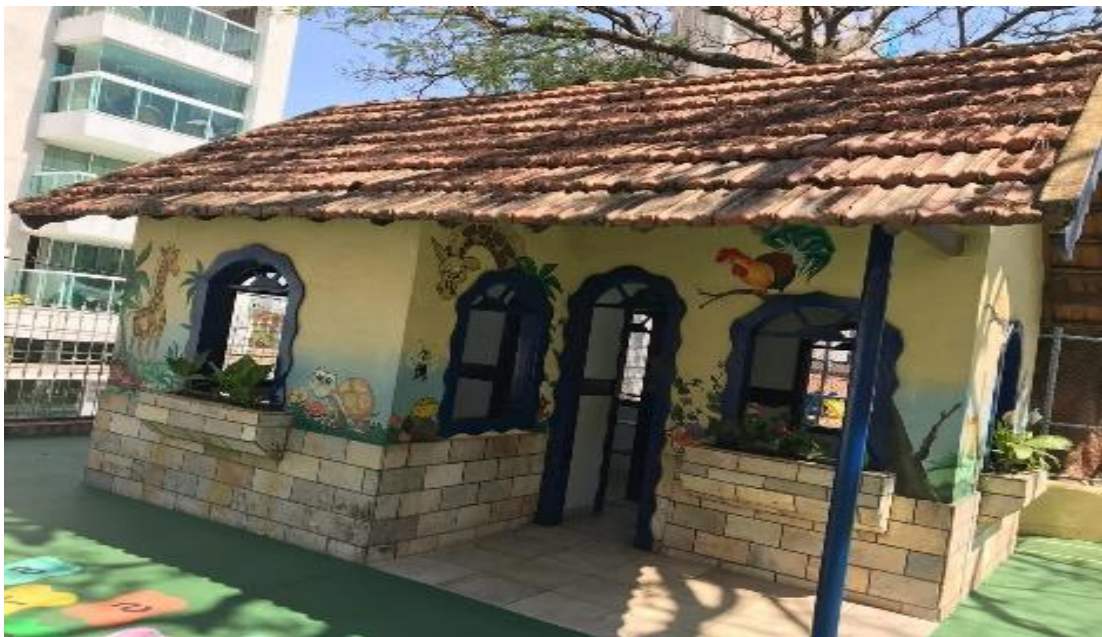
Figura 6 - Visão Frontal da Casinha de Alvenaria
