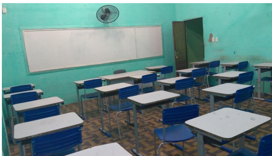
Fotografia 4 - Sala de aula 4
