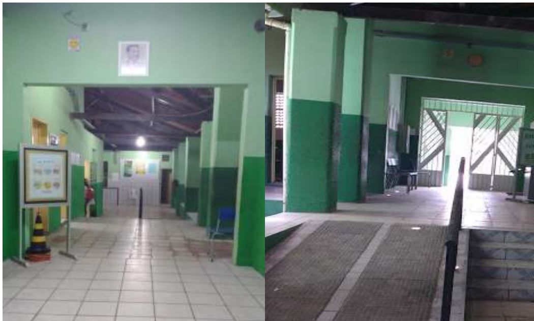
Imagem 5 – Galerias e entrada principal da escola
