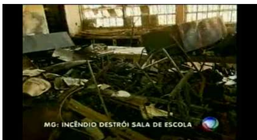
Figura 3 – Incêndio atinge escola em Santa Luzia – MG
