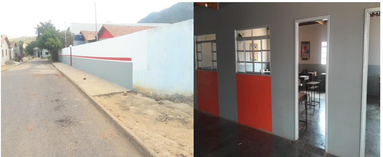
Figura 7 – Fachada do Anexo Brejo Grande
