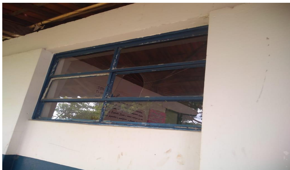
Figura 4 - Vidro danificado II
