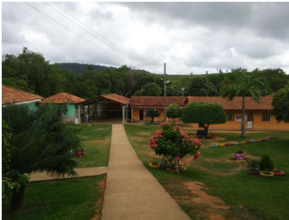
Vista parcial da E.E. José Teixeira Franco/ Rampa de acesso
