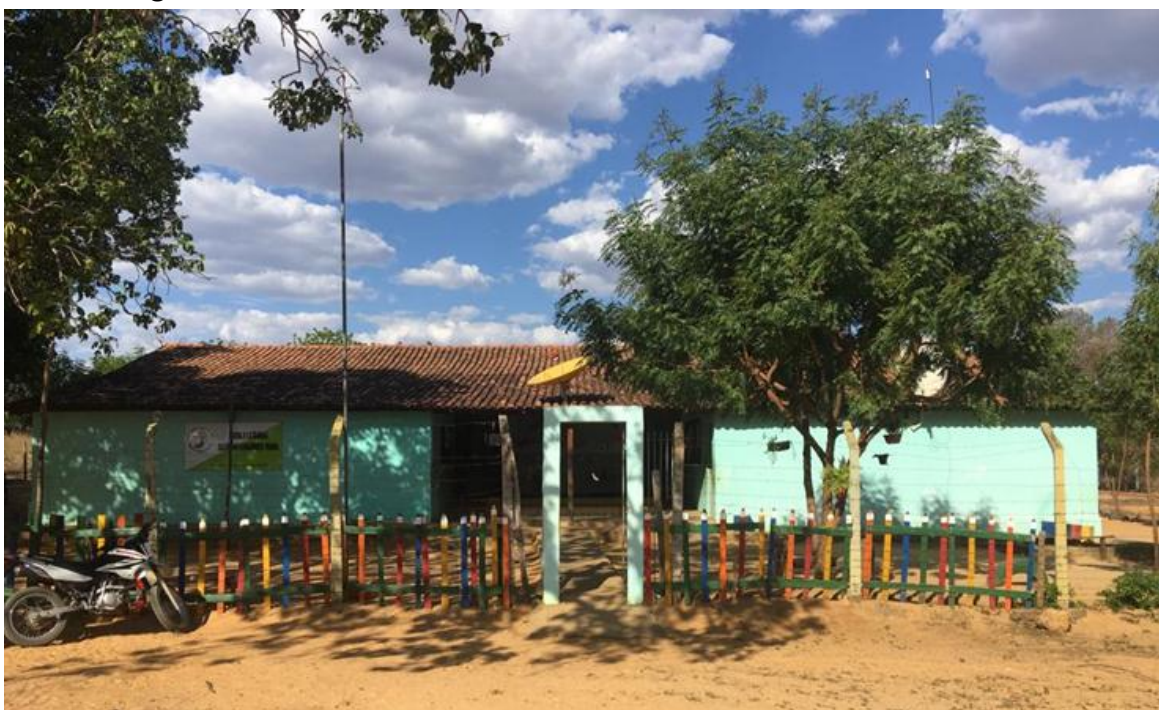
Figura 1 - Fachada da Escola Estadual Antônio Fernandes Viana
