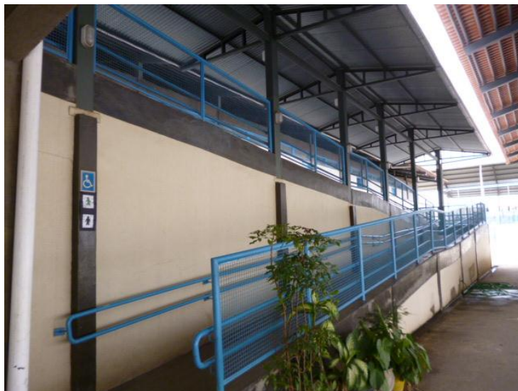
Figura 17 – Rampa de acesso ao segundo pavimento da Escola Estadual C
