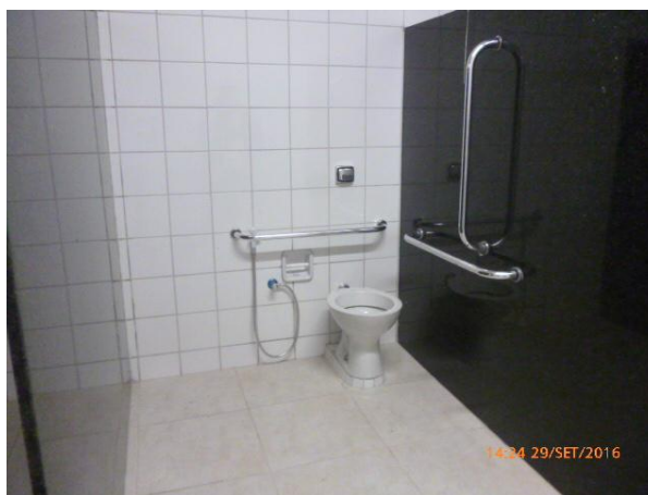
Figura 13 – Banheiro adaptado para pessoas com deficiência física da Escola Estadual B
