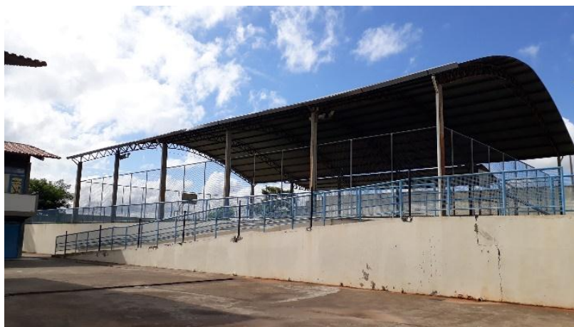
Figura 18 – Rampa de acesso à quadra da Escola Estadual C
