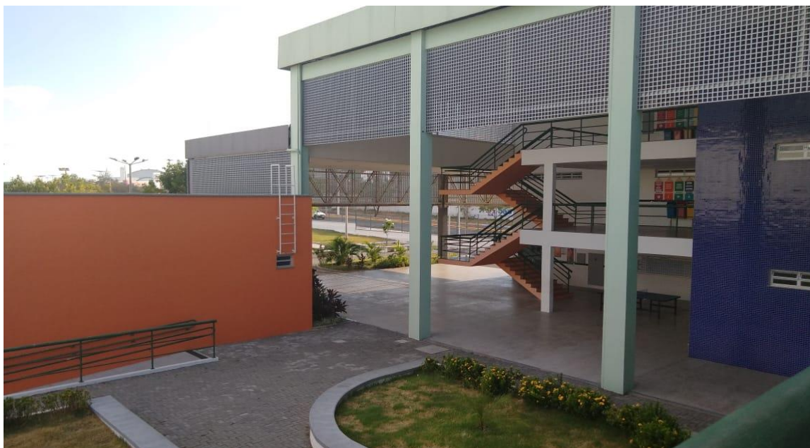
Figura 8 - Lateral do Prédio Principal
