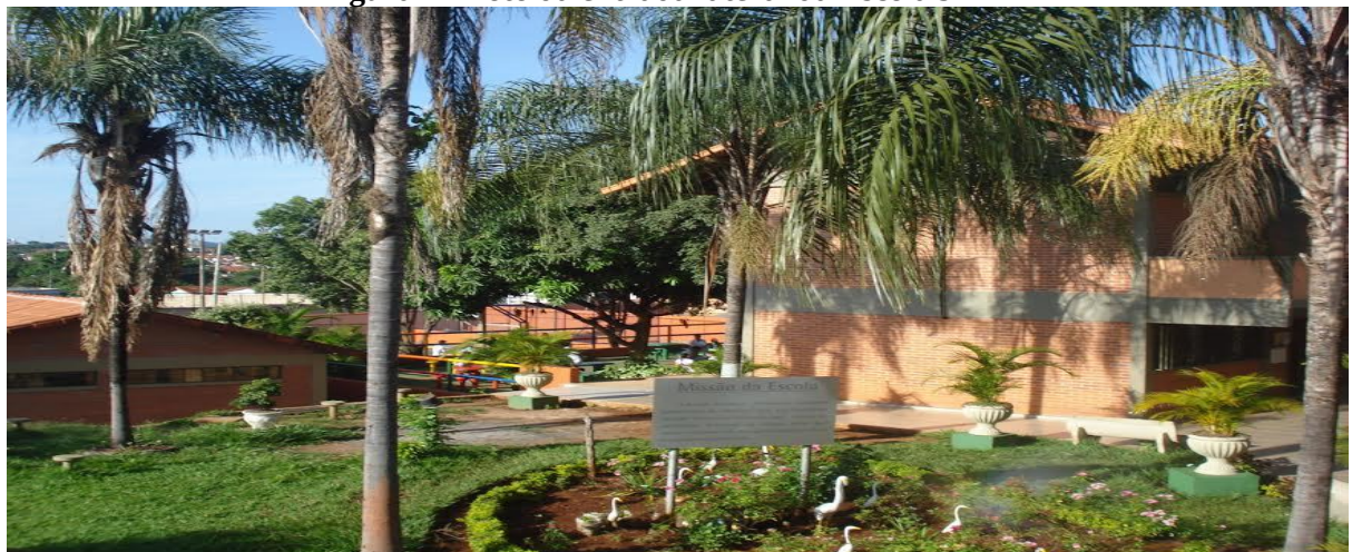
Figura 4 - Foto da entrada lateral da Escola JK
