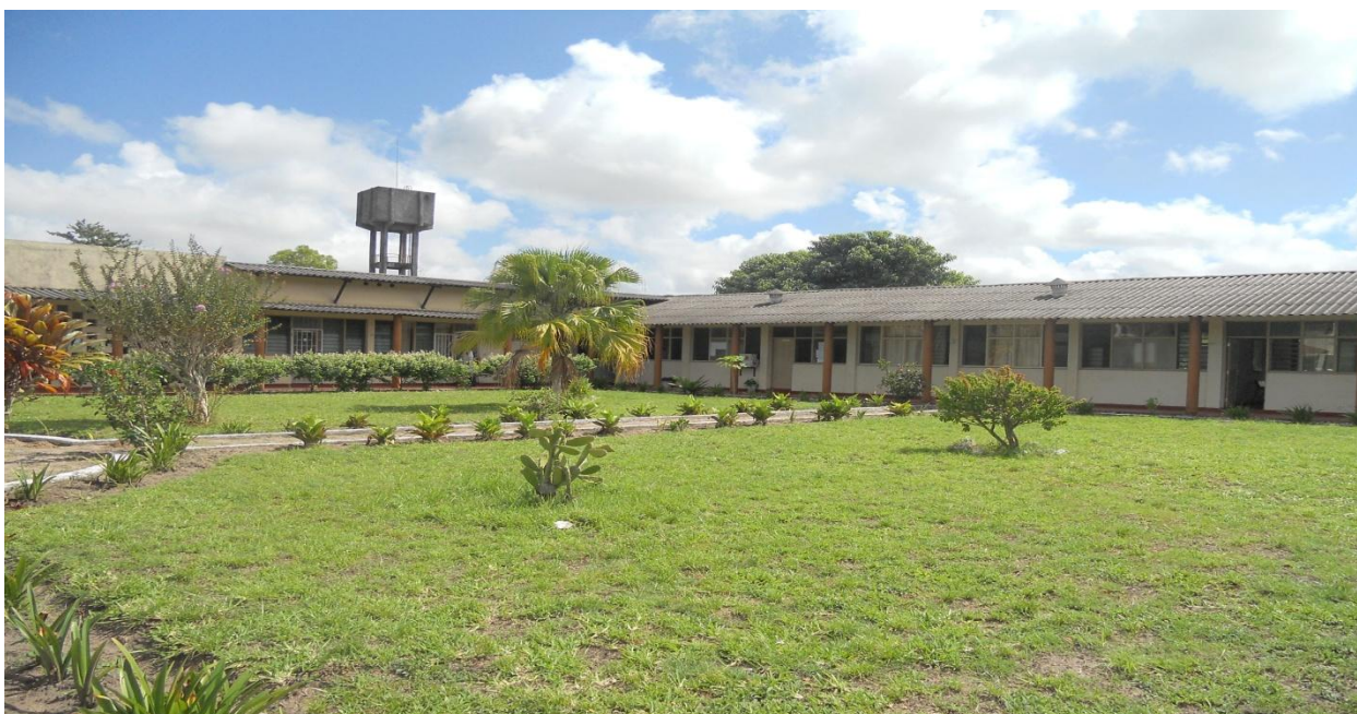
Foto 2: Salas dos formadores e gabinetes dos gestores
