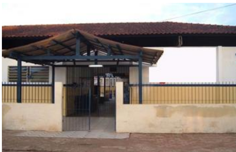
Figura 5 - Estrutura pós-reforma da EEMS – Reforma (1999/2001)
