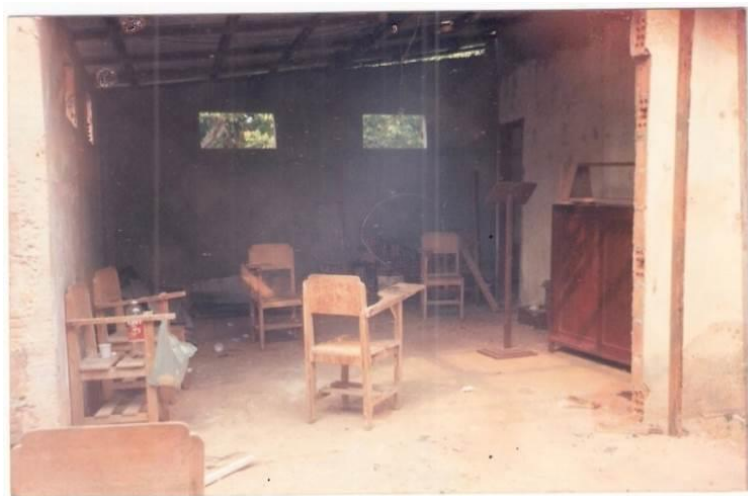
Figura 4 - Estrutura Interna Inacabada da EEMS
