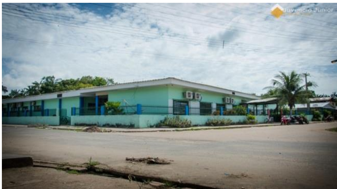
Figura 6 - Estrutura atual da EEMS – Reforma (2012/2013)
