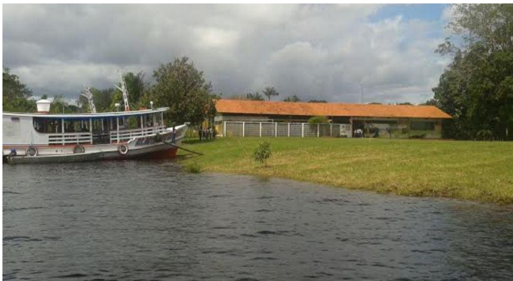
Figura 7 – Vista da Frente da E.E. Nossa Senhora do Rosário. Fonte: Acervo da escola.
